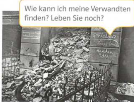
zerstörtes Haus in Hamburg
